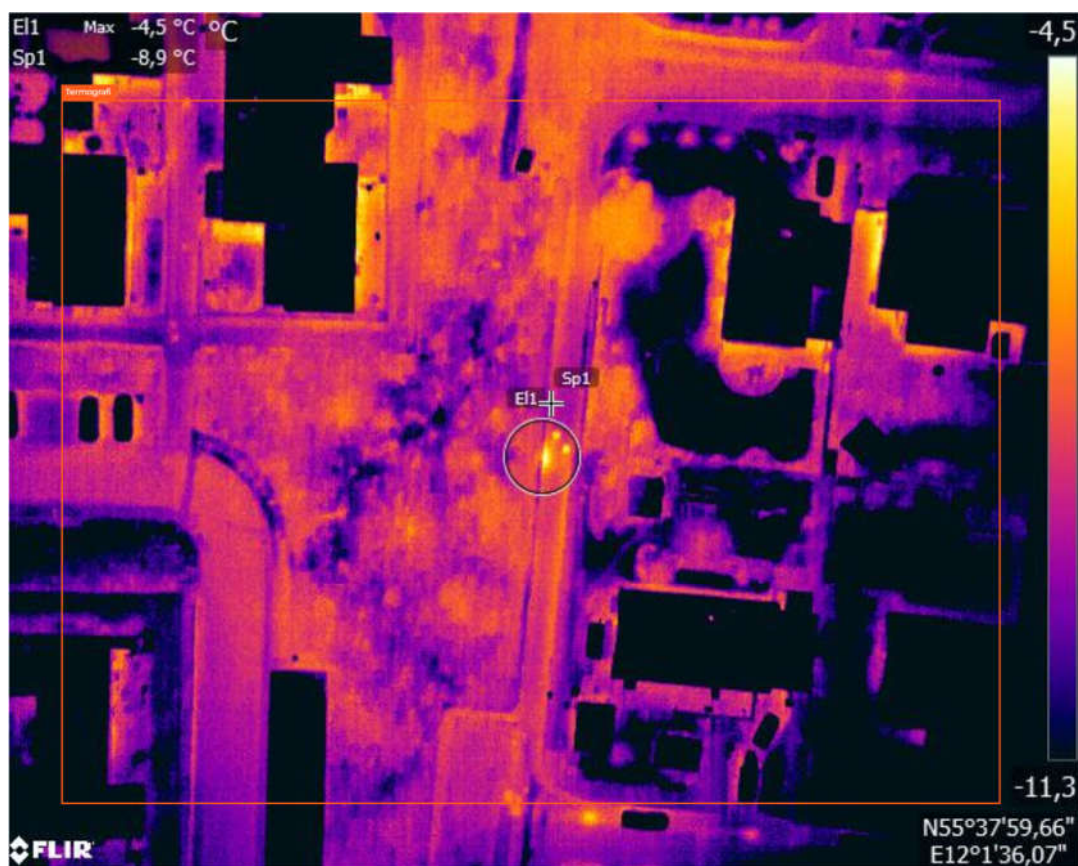
Eksempel på lokaliseret brud der skal udbedres.
